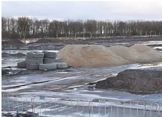
Bouwrijp maken van Het Venster
